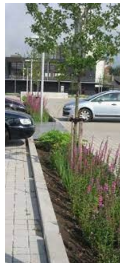
Figur 4. Eksempler på regnvandsbed på en parkeringsplads.
